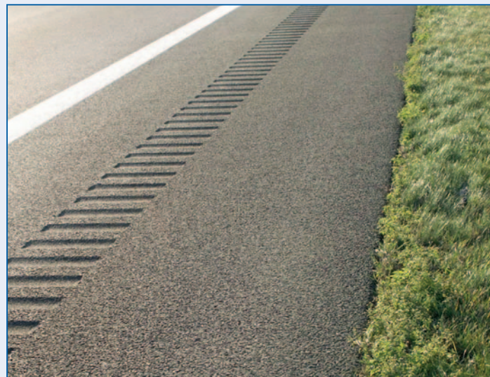
Eingeprägte Rüttelstreifen an Autobahnen erhöhen die Verkehrssicherheit
