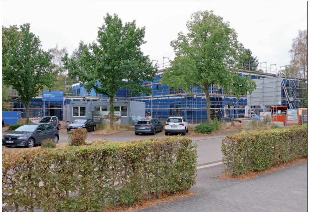
Insgesamt 9 Millionen Euro wird der Kindercampus in Hasborn-Dautweiler kosten. Die Freiwillige Ganztagschule und der Kindergarten werden dort künftig ein gemeinsames Zuhause finden.
