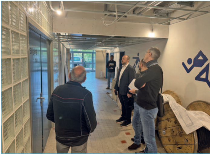
Bürgermeister Benjamin Schmidt bei der Inspektion der Baustelle
