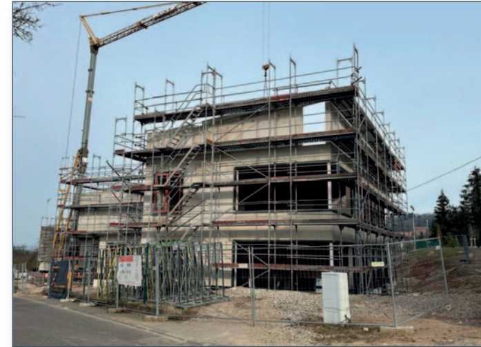
Hier entsteht Großes für die Kleinsten: Der Rohbau der neuen Kindertagesstätte in Humes ist fertiggestellt. Bald schon kann es mit dem Innenausbau losgehen. Foto: Gemeinde Eppelborn/Mayer
